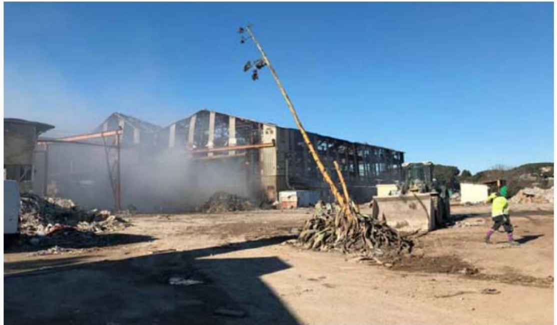
Les travaux de démolition sont en cours pour permettre aux pompiers d'éteindre le feu qui continue d'émettre des particules toxiques. Ils devraient durer jusqu'au lundi 10 janvier. PHOTO P.B.
